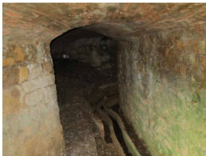
Rigoles aménagées dans le sol.
