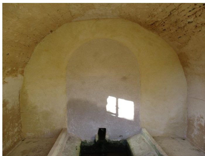
Intérieur du lavoir de la fontaine des Forges rénové en 2016 par un stage.
