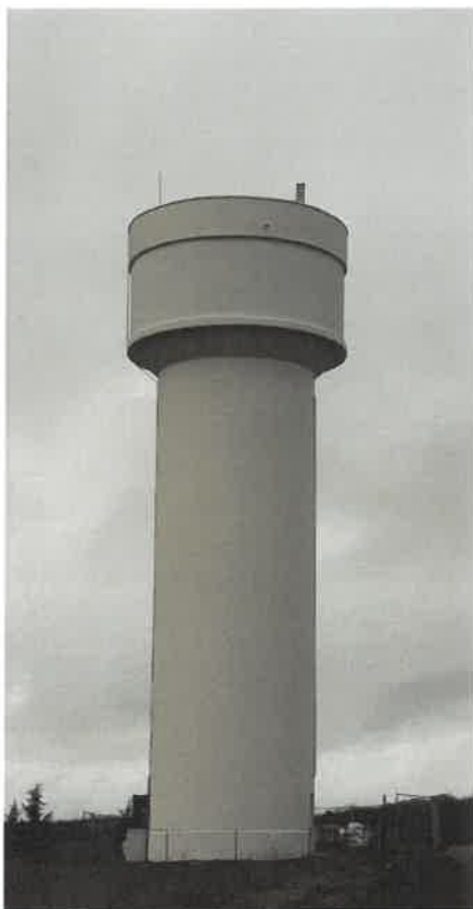
Hauteur totale : 22m75 Capacité : 130m3
