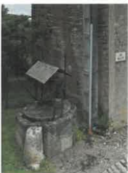
Puit rue Malat
