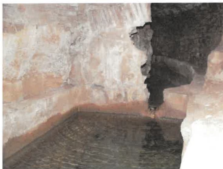
6-Amont du bassin et accès à la source
